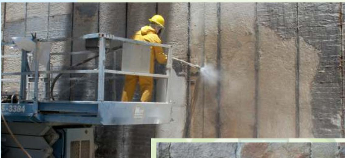
Пясъкоструйната обработка позволява почистване на повърхността от стари покрития, окисляване и ръжда или за да получите основа, която осигурява добро сцепление за последващи антикорозионни или защитни обработки.
